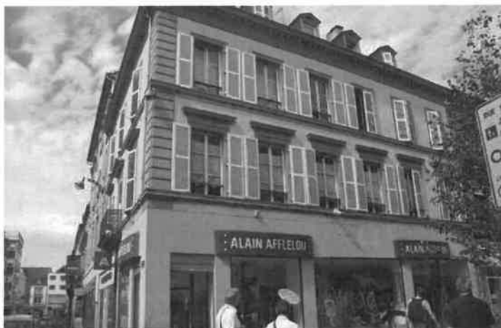
n°2 rue de la Chapelle : tous les éléments de modénature en pierre sont réalisés en grès beige laissé naturel (ni enduit, ni peint).
