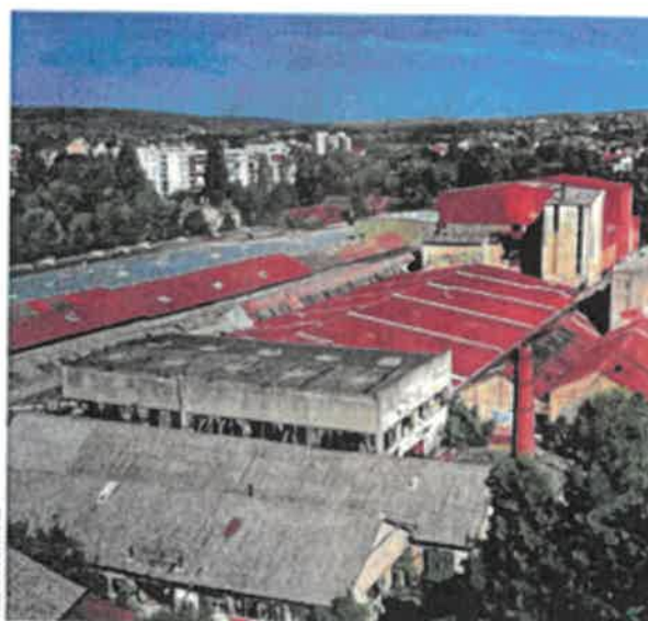
La Ville de Sarreguemines lancera cet automne une concertation publique préalable à l'aménagement de ses anciennes faïenceries.
